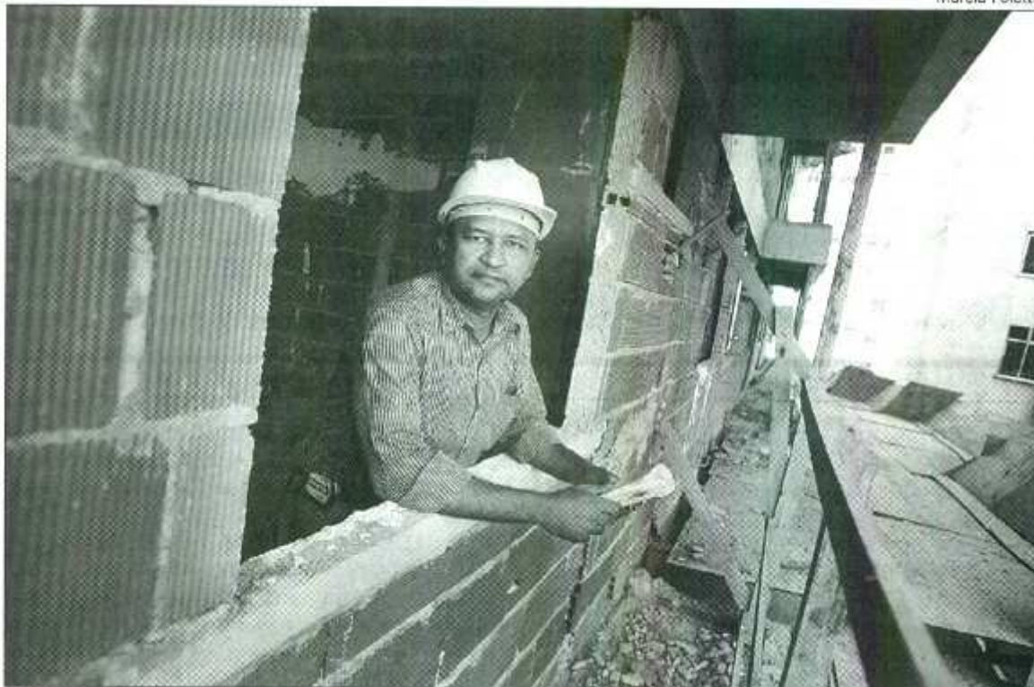
MANOEL JOSIVAN, 27 anos de construção: ele conseguiu emprego menos de 30 dias depois do fim da última obra
