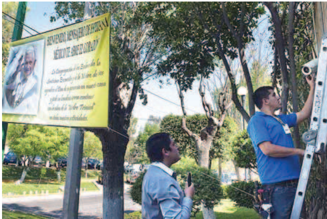
Dos empleados de seguridad instalan una cámara de vigilancia en la entrada del colegio de Mrañales donde el papa pernoctará las tres noches en una habitación del primer nivel.
