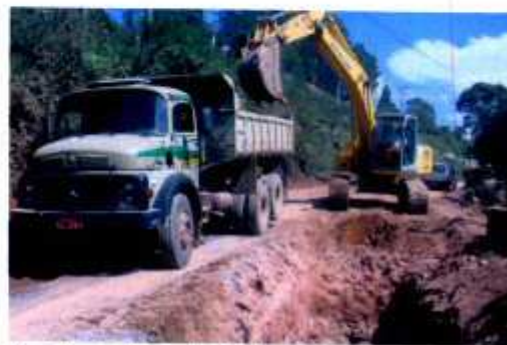
Obra de ampliação da rede de esgoto em Caxias do Sul (RS)
