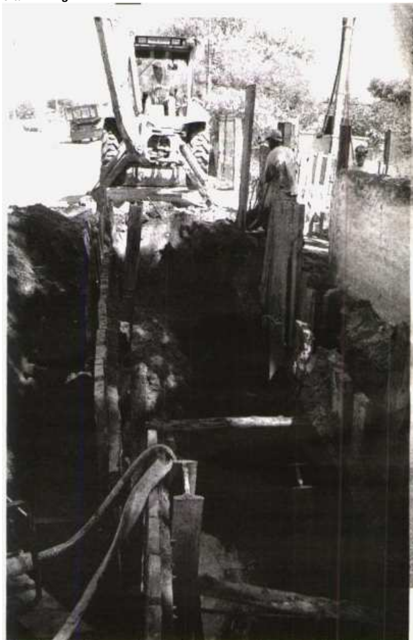
Obras incluem abertura de redes de esgoto nos bairros Restinga e Cavahada
