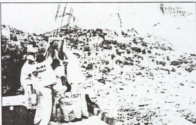
FISCAS DA Prefeitura, sob proteção policial, derubam coluna de construção ilegal na Favela da Rocinha. Era parte de um prédio em sete andares, em fase final de edificação, que crescia em área de preservação ambiental, com Mata Atlântica natural. Na operação conjunta, foram detidas três pessoas e demolido um depósito de gás. Os terrenos no local eram vendidos por até R$ 10 mil. PÁGINA C1
